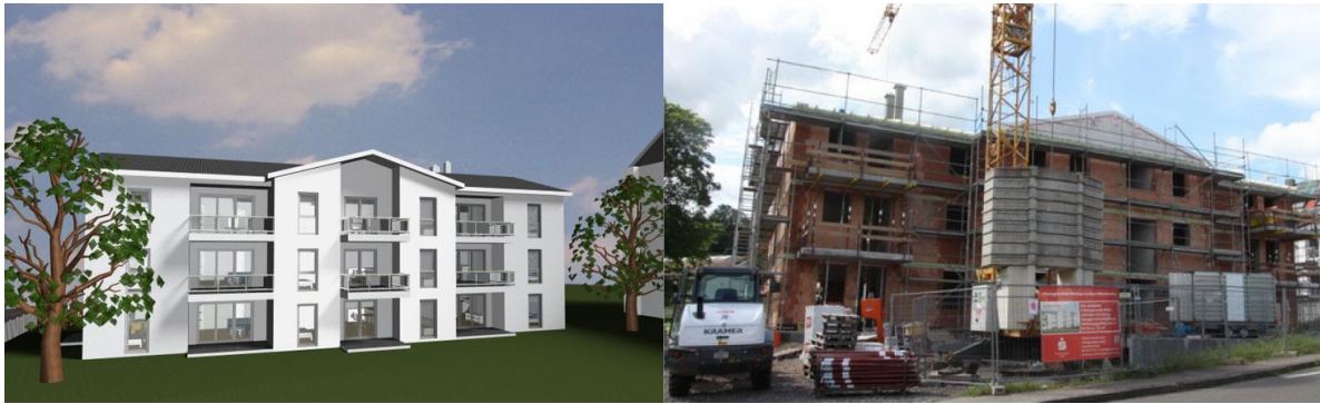
Animationsbild und Baufortschritt Mitte Mai 2024, Ringstraße 31 in 66907 Glan-Münchweiler
